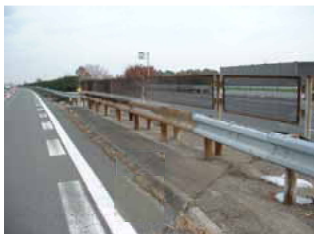
《中分防護柵(整備前)》
