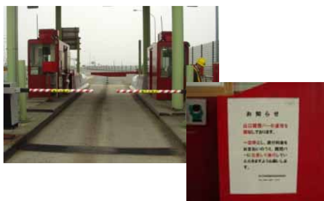
《一般レーン(ETC専用以外)の開閉バー設置》
