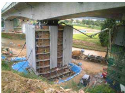
〈橋脚耐震補強工事の状況〉
