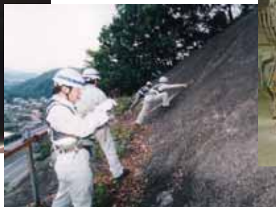
《のり面の点検》
