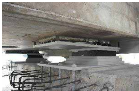
支承取替（鋼製 ゴム製）
