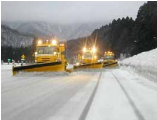
〈除雪作業状況〉
