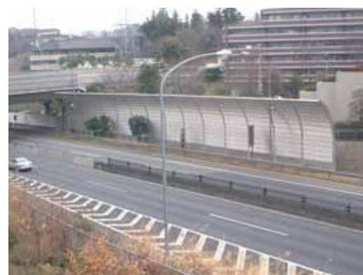
《遮音壁設置状況》
