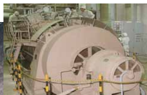
《受配電設備の点検》
